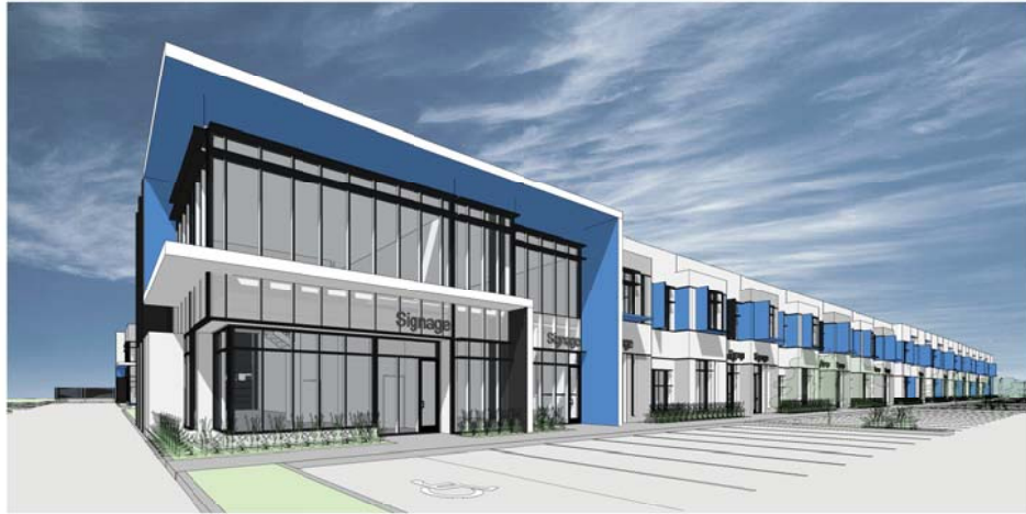
Bldg_1_from drive aisle
